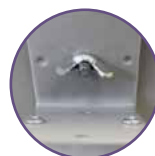
Fissaggio con galletto e bullone
